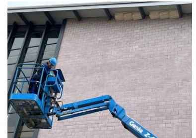
Montage bei Firma Imhof
